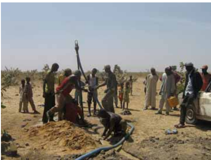
Der grosse Einsatz auf der Suche nach Wasser in Mada ist noch nicht belohnt worden: eine von Hand durchgeführte – vergebliche - Bohrung
