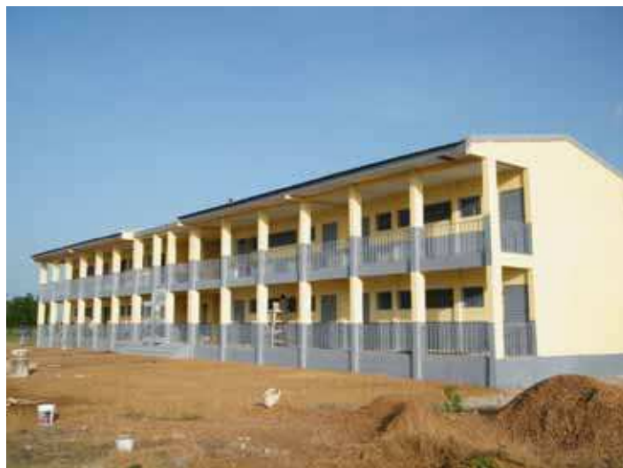
Das Hauptgebäude der neuen Berufsschule in Kousseri
