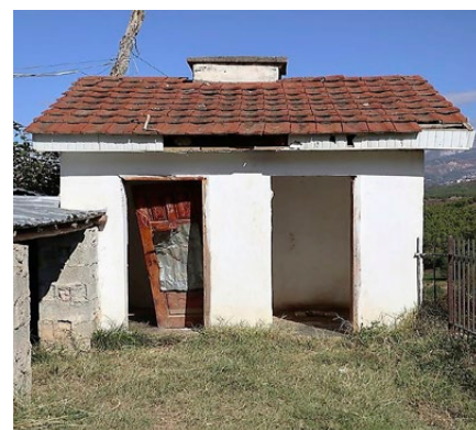
Die Toiletten im ursprünglichen Zustand
