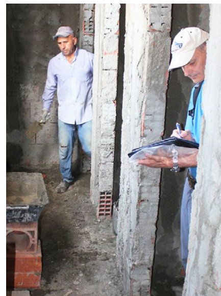
IPA zu Besuch während den Arbeiten (Juli 21)
