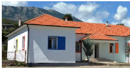
In neuem Glanz: Das Gymnasium von Muhurr
