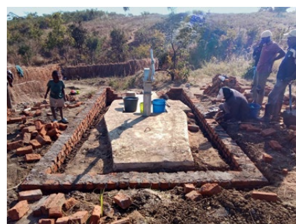
Der Mauerbau rund um den Brunnen: eine Eigenleistung der Dorfbevölkerung
