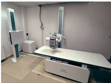
Das neue Gerät fertig installiert
